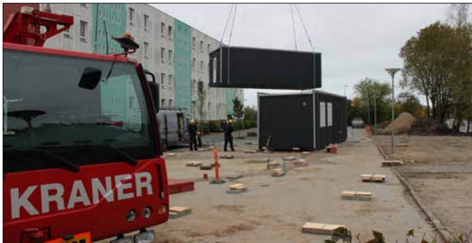
12 helt nye pavilloner sættes sammen to og to. De bliver til seks genhusning lejligheder, som beboerne i Chr. Koldsvej 20, inden længe flytter ind i.
