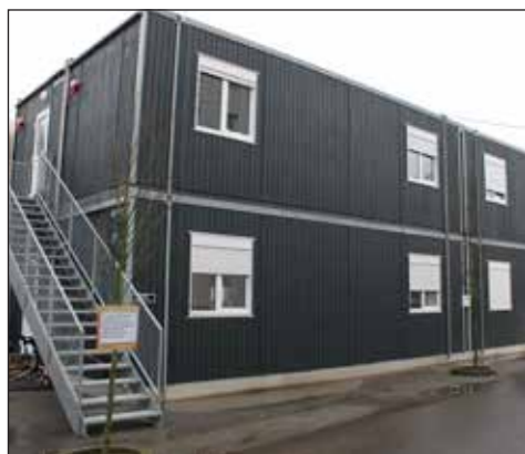
De 60m 2 pavilloner på Grundtvigsvej, skal huse en familie i 4 måneder.
