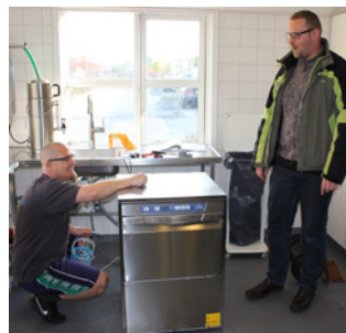
Ny opvasker installeres.
